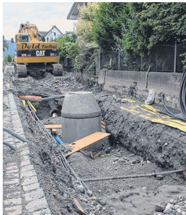
Aufwendige Kanalarbeiten stehen heuer im Bludener Ortsteil Halde an.
