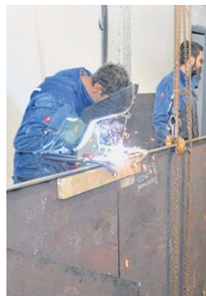
Der Innenausbau der Turnhallen läuft auf Hochtouren.
