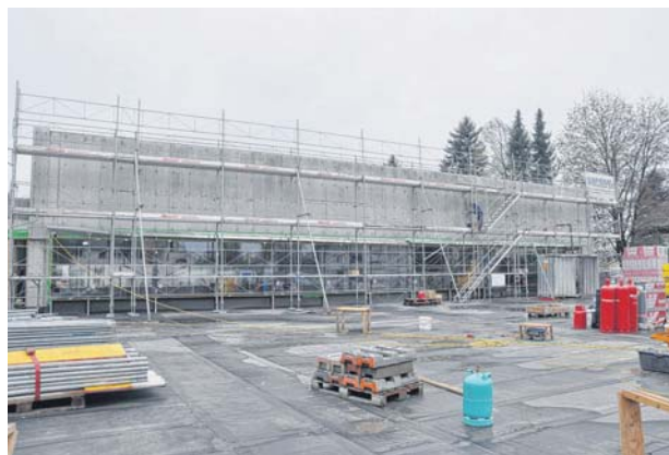
Der Neubau wurde bereits eingerüstet. Derzeit wird die Unterkonstruktion für die spätere Keramikfassade vorbereitet. FOTOS: HW
