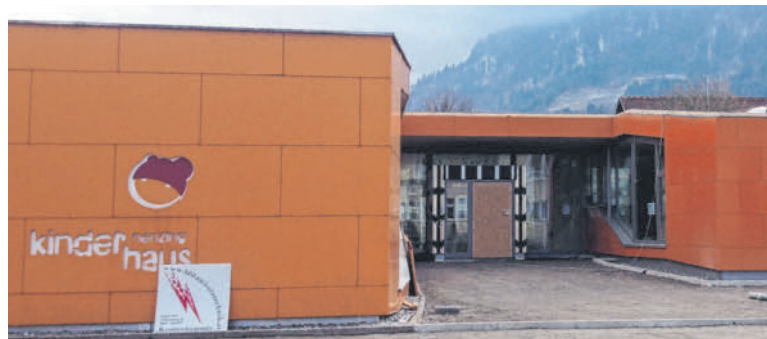
Die Bauarbeiten am Nenzinger Kinderhaus sind bereits bald abgeschlossen.
