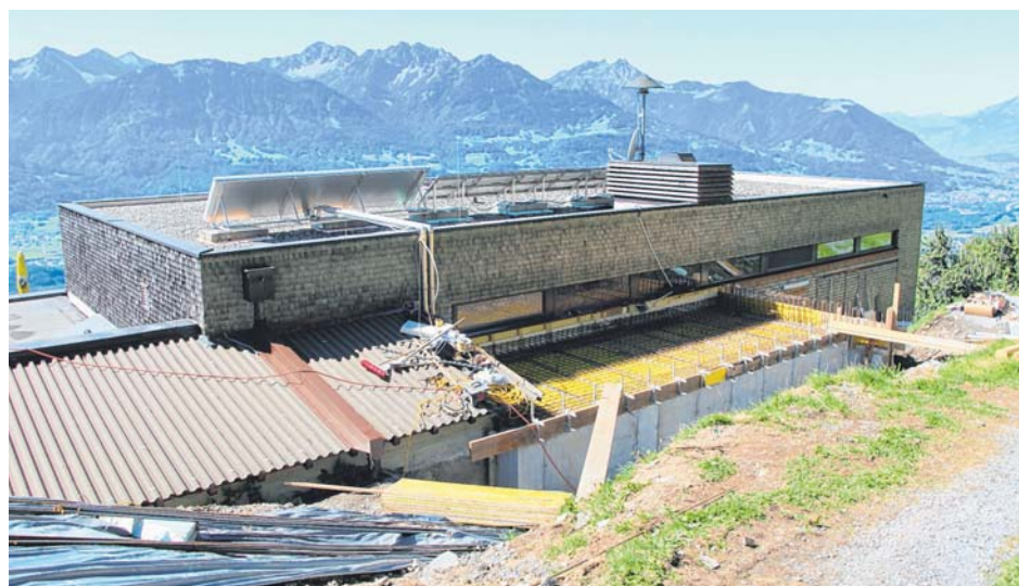
Der rund 55 Quadratmeter große Zubau auf der Nordseite des Gebäudes wurde bereits errichtet.
