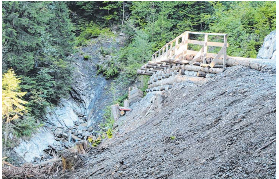
Die ersten baulichen Maßnahmen beim Pfuidetschbach sind bereits zu erkennen.
