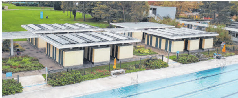
Die Solar-Hybridanlage im Gartenbad St. Jakob im Basel.
