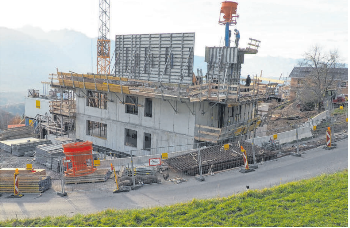
Das erste Mehrfamilienhaus in Dünserberg nimmt bereits Formen an.
