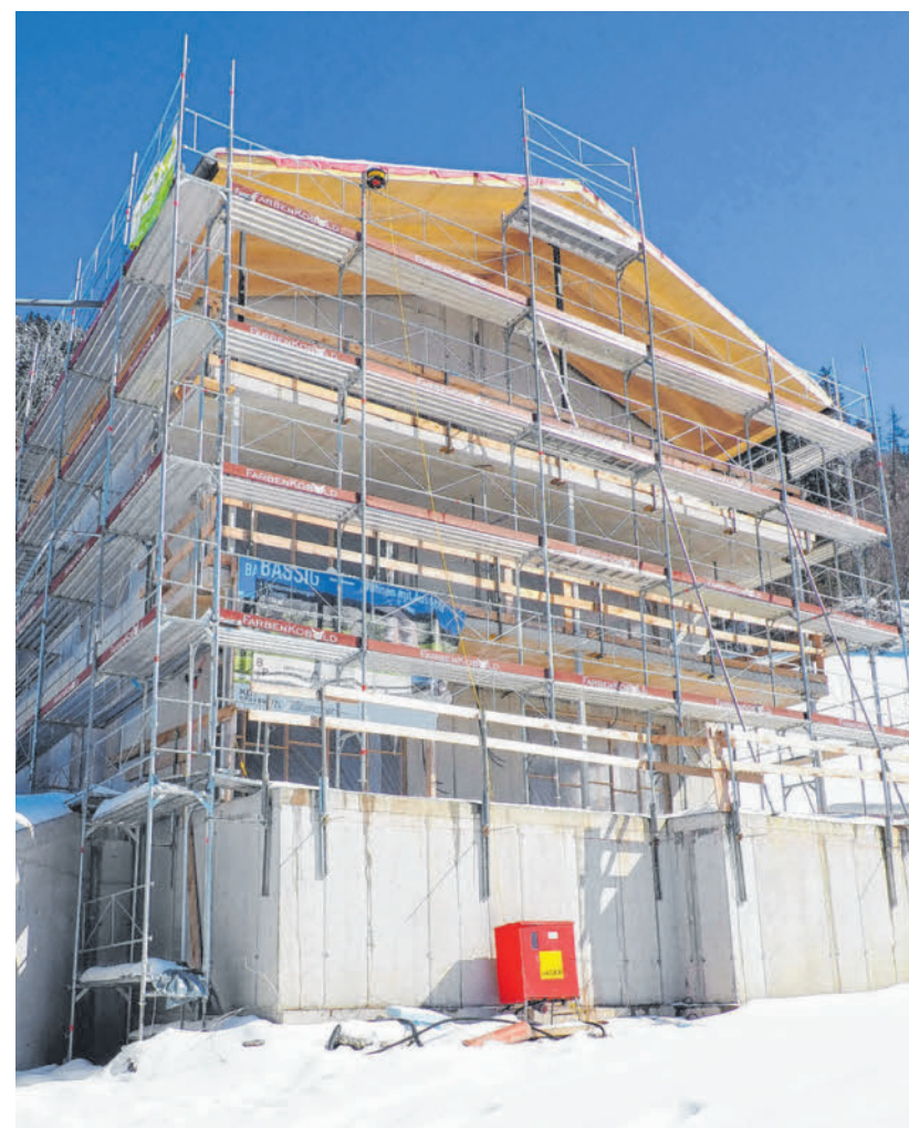
Aktuell wird das erste Mehrparteienhaus in Dünserberg errichtet. Das ist aber erst der Anfang – die Gemeinde arbeitet an einem Konzept für den Ortsteil Bassig.
