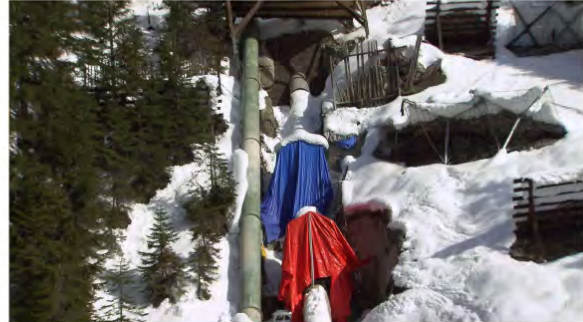
Foto: ORF Die alten Rohre sind noch überirdisch sichtbar
