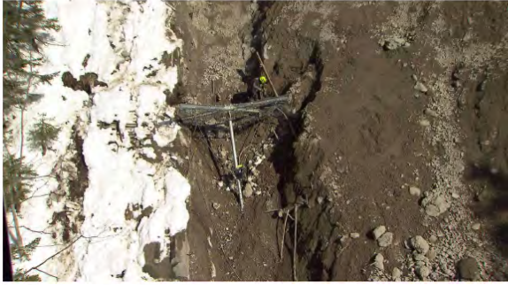
Foto: ORF Die Rohre werden unterirdisch verlegt
