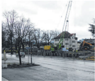
Die Schulstraße ist für die Arbeiten am Betreuten Wohnen gesperrt.
