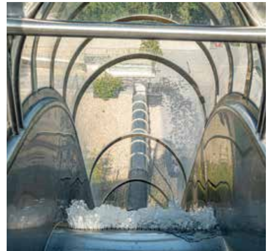
Vom Dach des Aufsichtspavillons führen die Edelstahl-Rutschen von Wiegand hinab.
