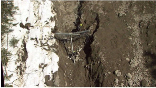
Foto: ORF Die Rohre werden unterirdisch verlegt
