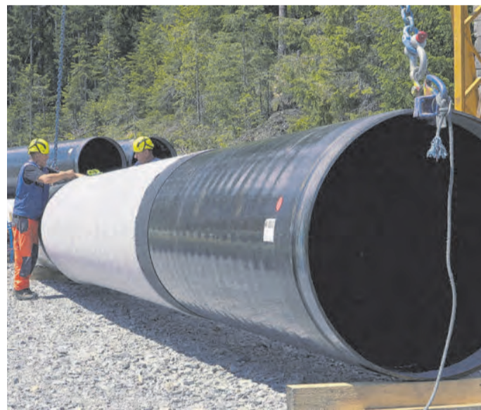
Arbeiten am vergrößerten Stollenrohr.
