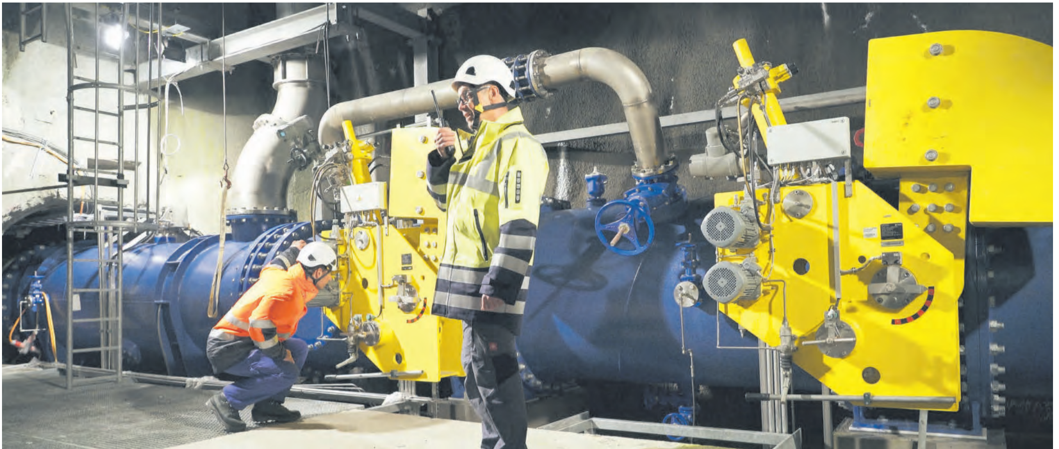
Trotz Covid-19 konnten die Arbeiten im vorgegebenen Zeitplan fertiggestellt werden.
