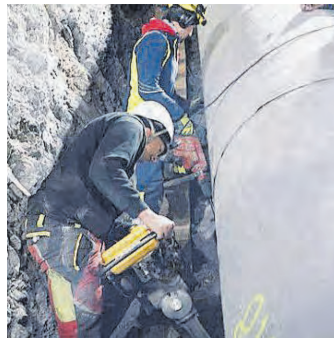
Rohrverlegung im steilen Gelände.
