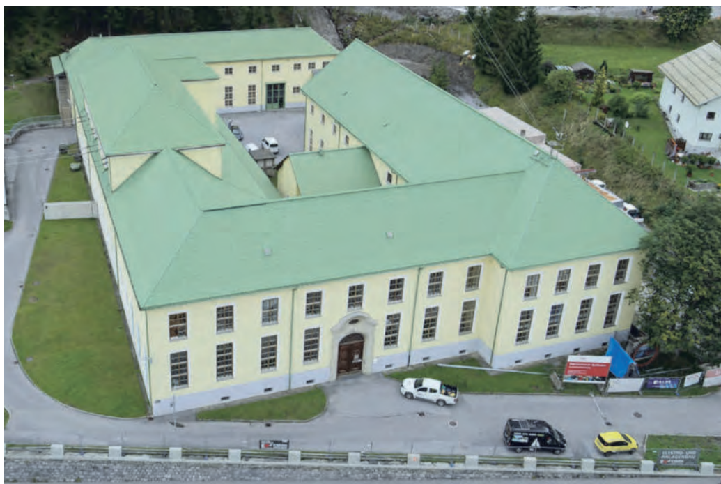
Das Kraftwerk Spullersee wurde vor fast 100 Jahren errichtet.
