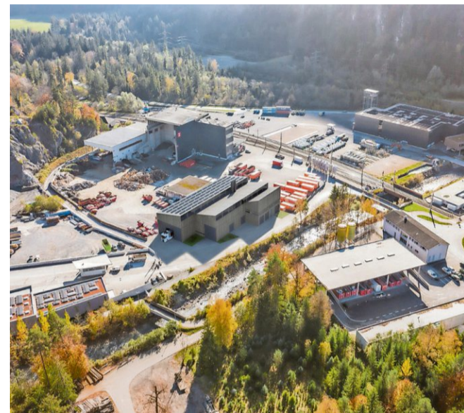
Die Stadt Bludenz, die Agrargemeinschaft Bürs und die illwerke vkw AG entwickeln gemeinsam ein nachhaltiges Wärmeversorgungskonzept.
