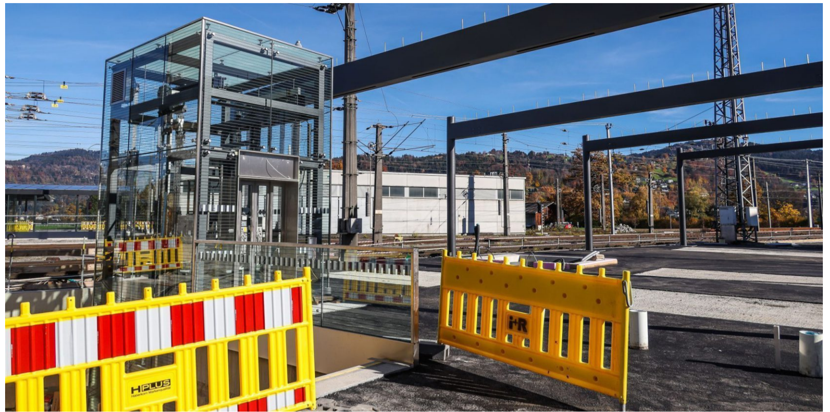
Die neue Haltestelle ist für 1000 bis 2000 Fahrgäste ausgelegt.
